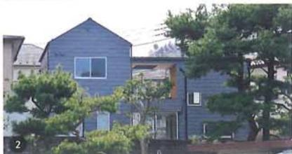
①外壁のガルバリウム鋼板による無機質さと、玄関ドアや2階の外壁に用いた木の温もりを対比させた印象的な外観デザイン。ガルバリウム鋼板は、職人が1枚ずつ手折りしたもの ②家のどこからでも眺められる隣地の松の木越しに、外観を望む
