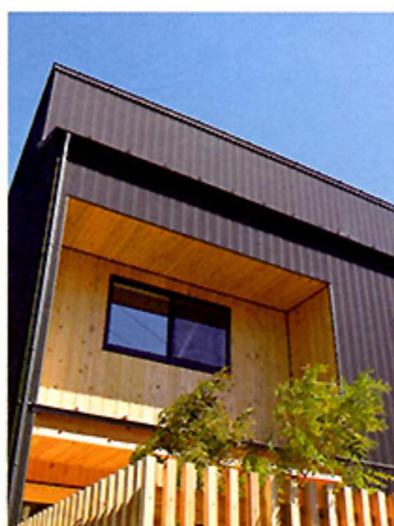
開口部は外壁面から後退させ、袖壁も付けて、雨や直射日光から保護
