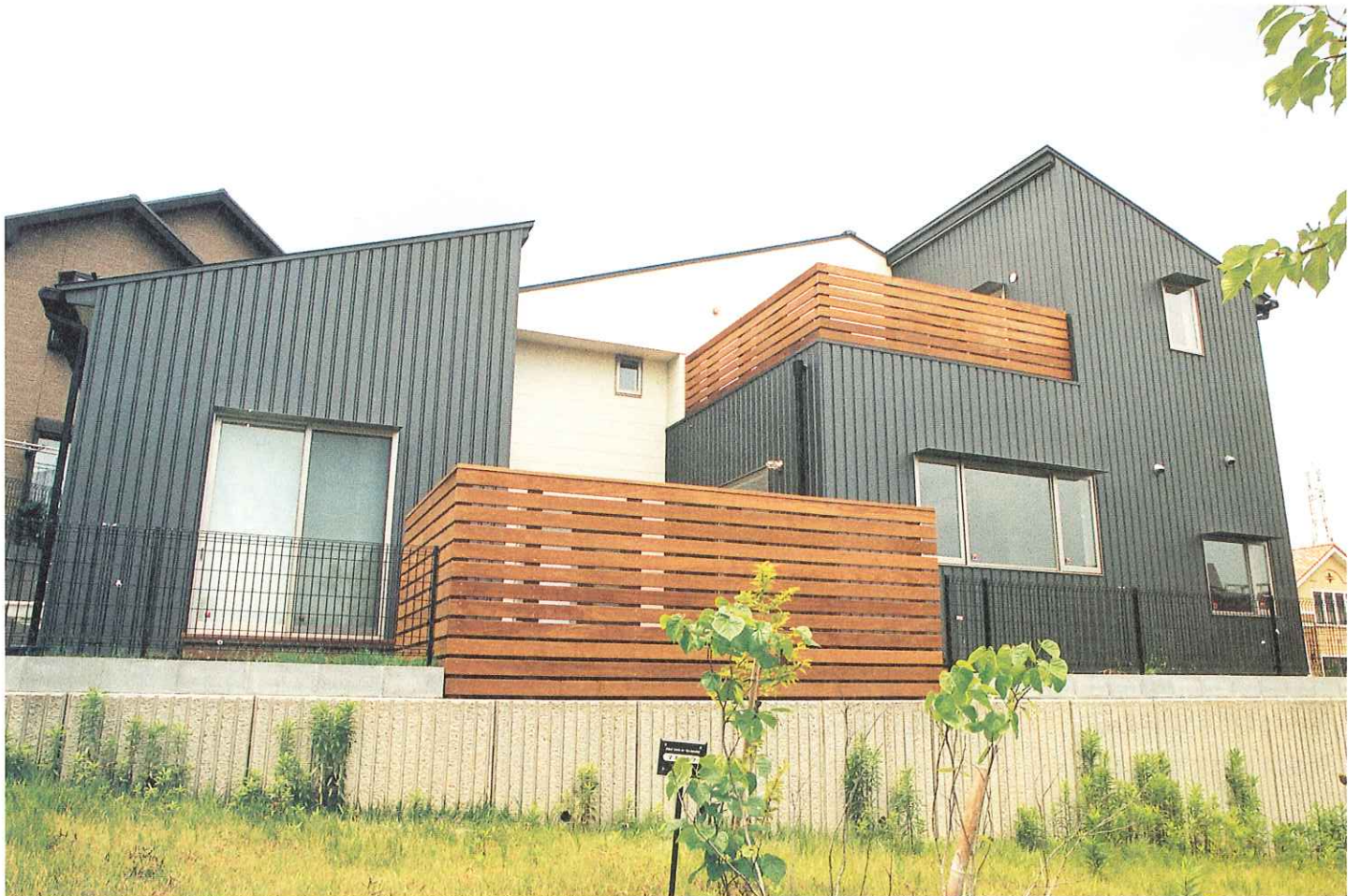
南向きに傾斜した高台という好立地を最大限に活かすように外観を設計した。黒いガルバリウム鋼板、白いサイディング、茶のウッドデッキという3色の対比により建物全体に奥行きをつくり、周囲の緑を引き立てるように配慮している。北側のアプローチは建物の高さを抑えて横への広がりをつくり、切妻大屋根の形状にして落ち着きのあるプロポーションを見せている
