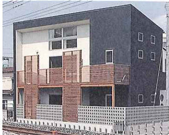
路沿いという立地を考慮し、目隠し格子を多く設置。夜の照明も美しい (川崎市H氏邸)
