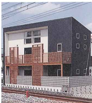
すっきりした印象の外壁に木製フェンスが絶妙なアクセントを加味した外観
